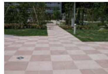
NTT病院関東外構工事
